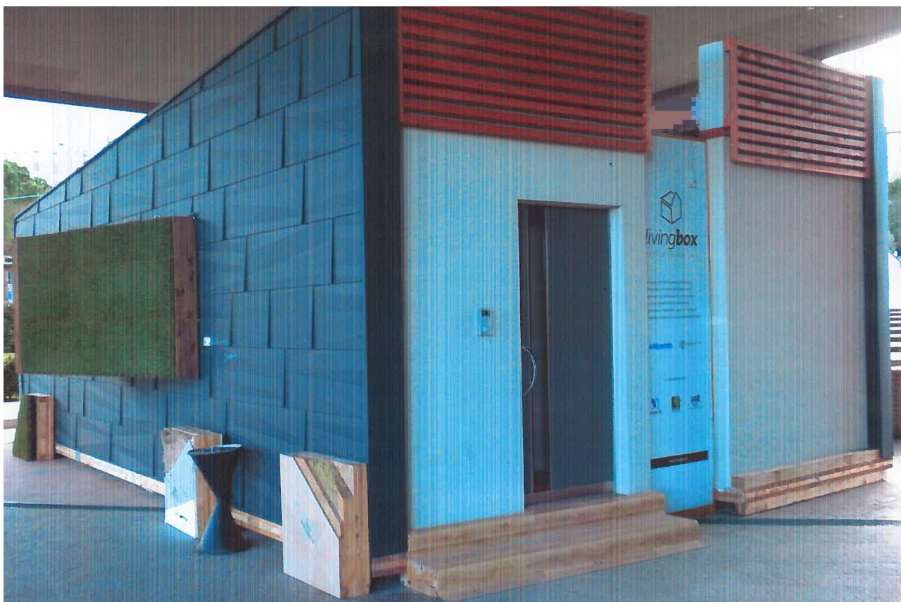
Vista Prospettica Anteriore/laterale sinistro
