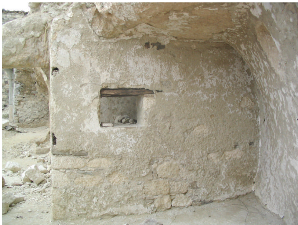
Fig. 14. Pietracupa, strutture murarie di completamento di una cavità (foto C. Ebanista).
