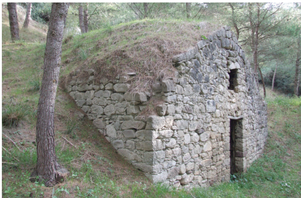
Fig. 25. Avancorpo in muratura di una cavità di Sant'Elia a Pianisi (foto G. Colavita).
