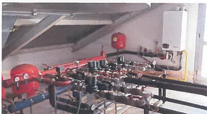
dimensionate per tale scopo. Le batterie calde di riscaldamento e di post-riscaldamento delle UTA sono alimentate da una rete di tubazioni collegata ai collettori su cui si attestano le reti radiatori e pannelli radianti. Le UTA di zona trattano l'aria di rinnovo, nelle quantità previste dalla normativa vigente, la quale attraversa i canali principali posti nei cavedi verticali e la rete orizzontale dei canali correnti nel
