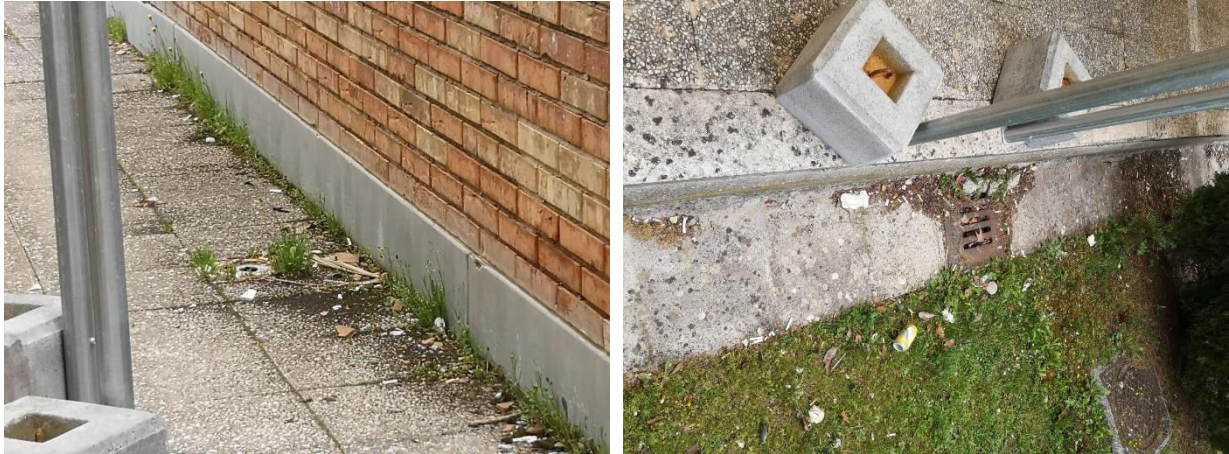
Figura 3 – Ostruzione del sistema di scarico delle acque meteoriche
