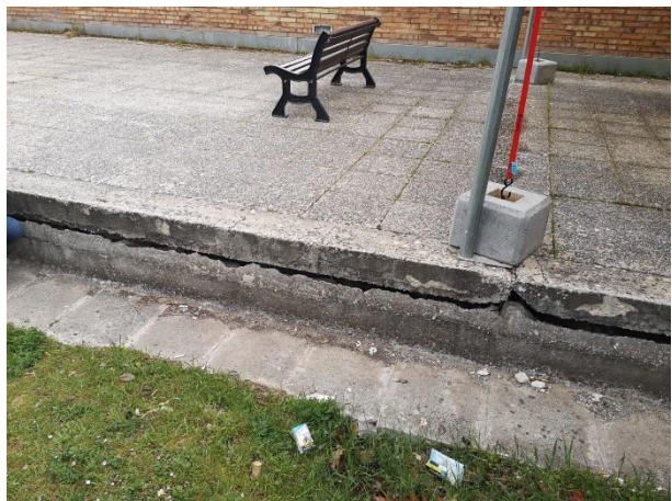
Figura 2 – Stato di fatto della copertura a terrazzo: ristagni, infiltrazioni e usura della pavimentazione
