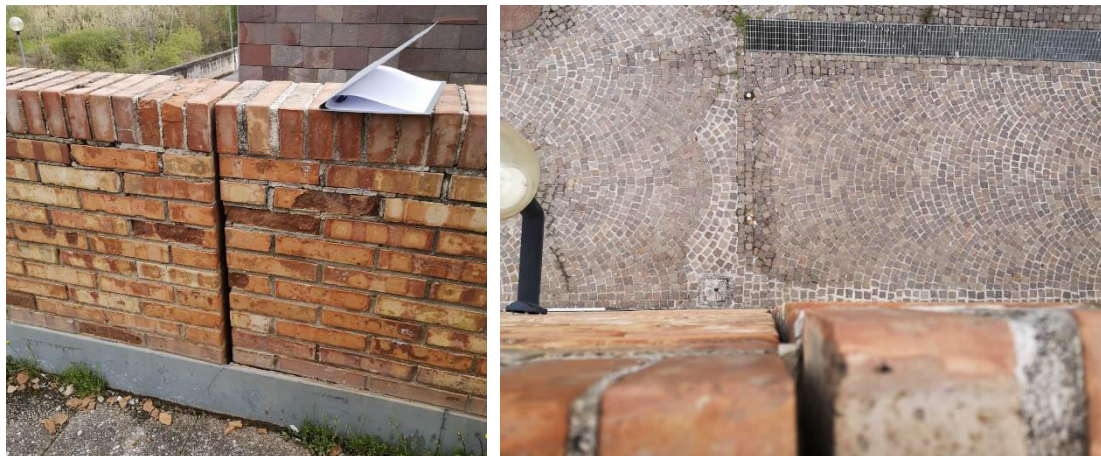
Figura 5 – Incipiente ribaltamento del parapetto di protezione
