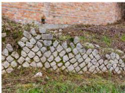
Paramento in *opus reticulatum* da sottoporre a intervento di stilatura profonda dei giunti, previo trattamento con prodotti biocidi.
