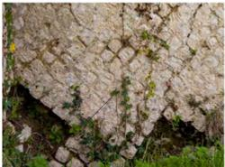
Manca nel paramento in *opus reticulatum* con fessurazioni nella parte superiore della muratura.
