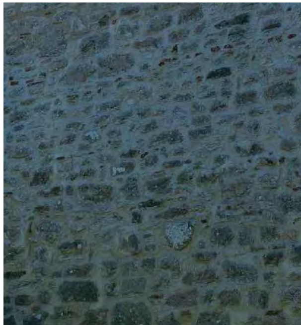
Figura 6: Tessitura regolare dei paramenti murari, vista dall'esterno.
