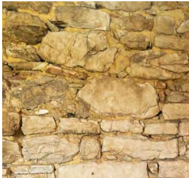
Figura 5: Tessitura regolare dei paramenti murari, vista dall'interno.
