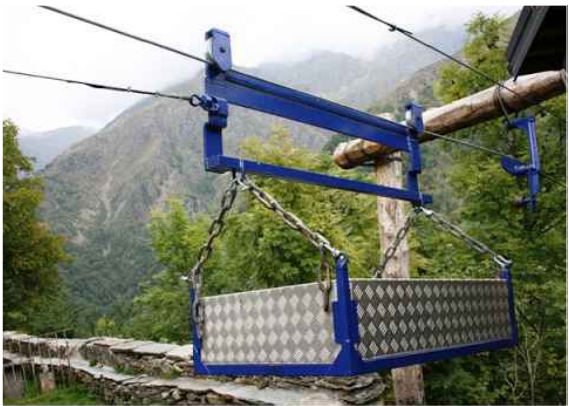
Teleferica provvisoria per il cantiere per il trasporto di materiale dall'area di scavo all'area di stoccaggio.
