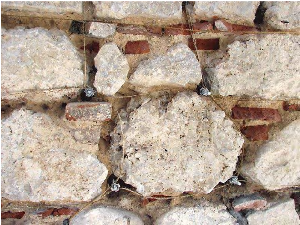
Figura 26. Esempio di ristilatura armata.
